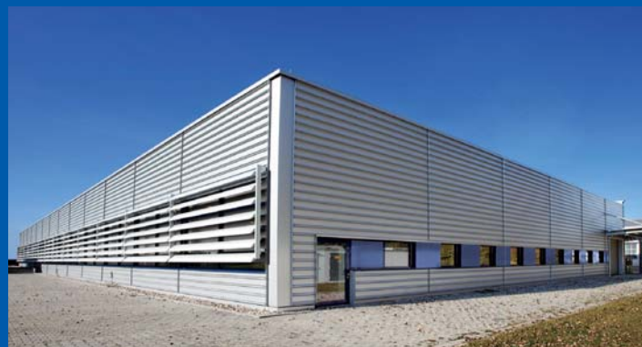
Neue Produktionshalle in Markt Indersdorf
