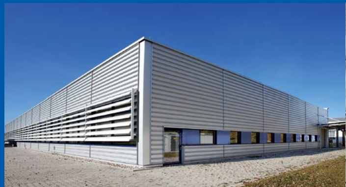
Neue Produktionshalle in Markt Indersdorf
